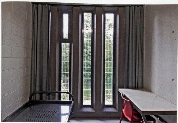
La découpe précise de la double paroi en béton à âme isolante donne aux chambres leur dignité. Le volume sous toiture les élève.
