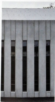
La découpe précise de la double paroi en béton à âme isolante donne aux chambres leur dignité. Le volume sous toiture les élève.
